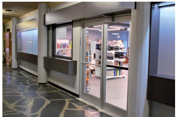
TRAVAUX DE RÉFECTION DE L'ENCRIER ÉTUDIANT
